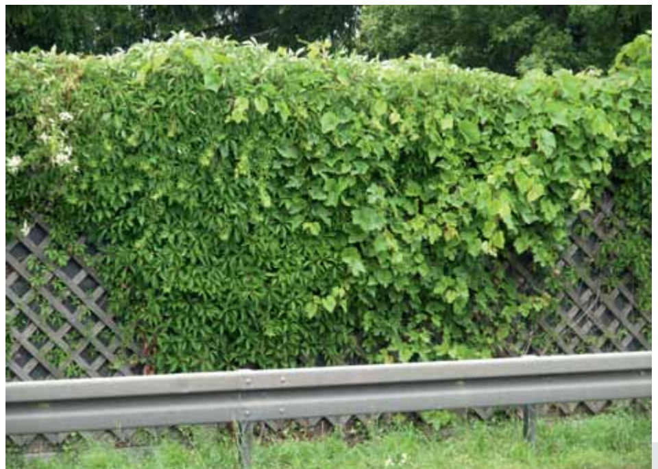
Bild 8: Vitis amurensis hat sich in einem Langzeitversuch an der Lärmschutzwand hervorragend bewährt.
